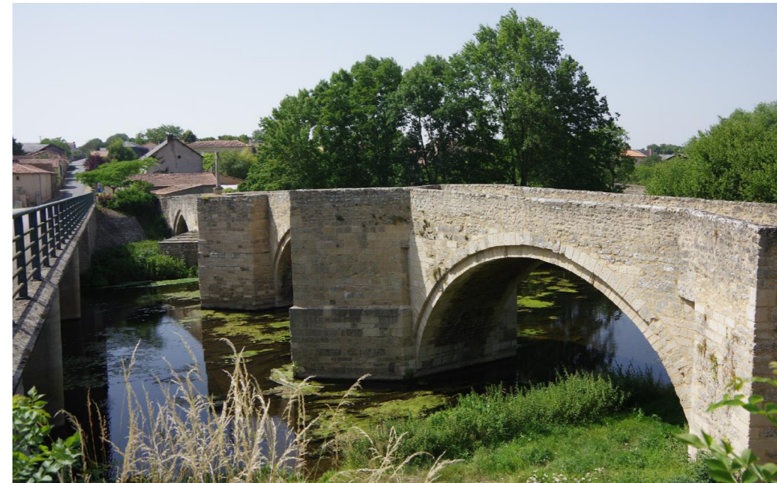
Photo 87 : Pont sur le Thouet (MH 6) à Saint-Généroux
