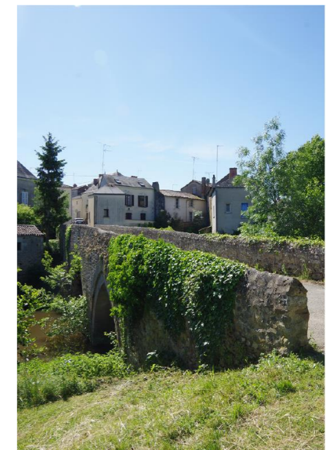
Photo 89 : Vieux pont (MH 1) dans son écrin bâti à St-Varent
