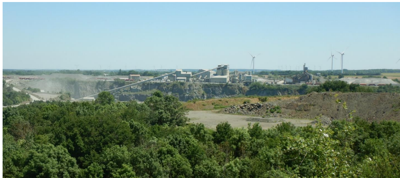
Photo 60 : les installations annexes à la carrière de la société Noubleau
